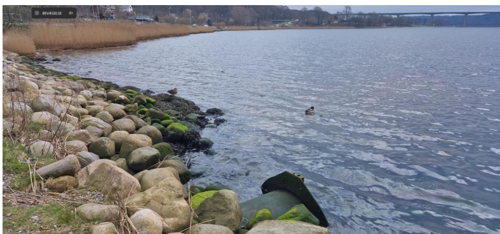
Figur 3-6 Fra projektområdets nordvestlige hjørne mod øst. Her ses regnvandsudløbet og kystsikringen af kampesten i forgrunden og rørsumpen af tagrør i overgangen mellem land og vand.
