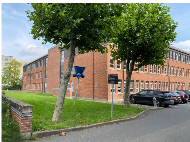
Figur 5: Ved den vestligste indkørsel til Boulevarden 19A og B står to platantræer. Plantantræerne kan med fordel bevares. Tv. ses en lav rød mur i skel.
