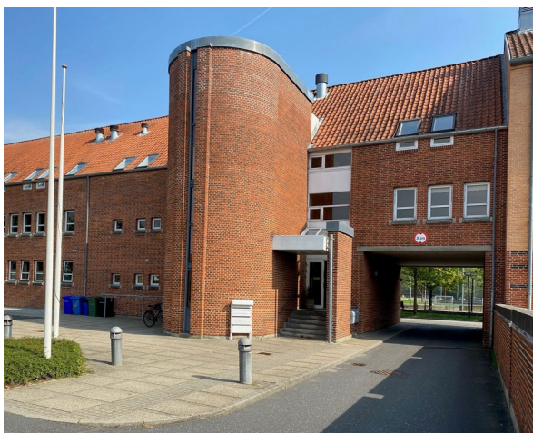
Figur 2: Eksisterende karrébebyggelse Enghavevej 10 set fra gårdrummet.
