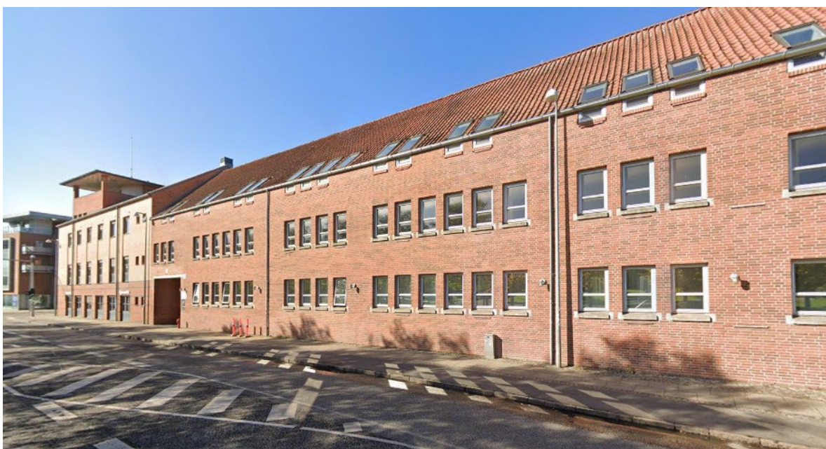
Figur 4: Eksisterende karrébebyggelse Enghavevej 10 er opført i 1989. Bygningen er opdelt i tre facadepartier ved at vinduerne er samlet og der er ophold i vinduesrækken omkring nedløbsrør. Dertil er bygningen opført med port, som er kendetegnet for den gamle bymidte.
