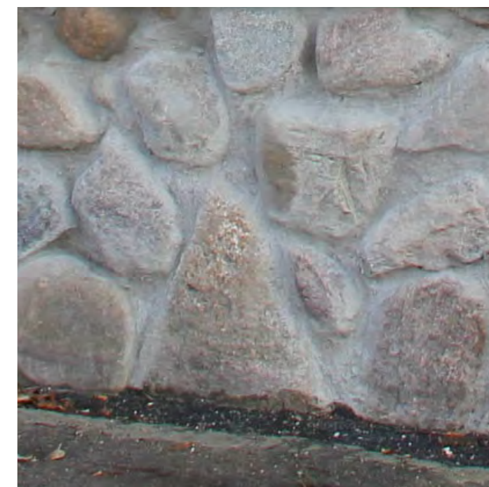
Støttemur ved gårdsplads af stablede marksten med fuge. Marksten evt. fra lokal landmand.
