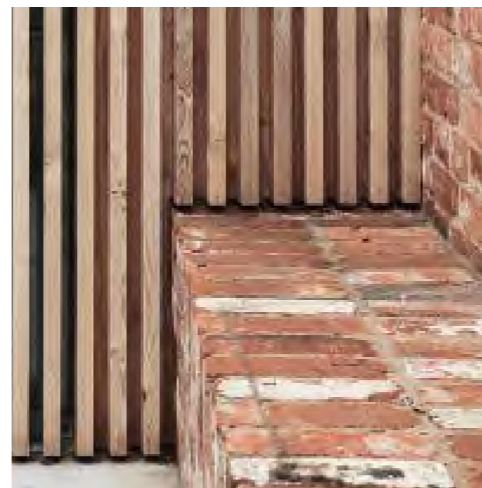
Alternativt røde mursten fra gammelt hovedhus. Som trin i terræn og ved indgang, gulv i ny garage og som bede i køkkenhaven.
