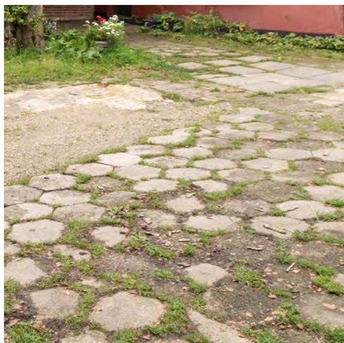
Kombination af knust tegl og genbrugstegl som stier.
