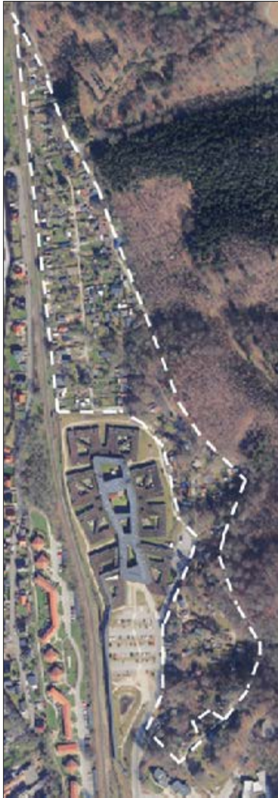
Figur 4. Lokalplan-området set fra syd. HF Nordly kan opdeles i et nordligt og et sydligt område. Det nordlige område er åbnet og forholdsvis fladt og skrånende op mod skoven. Det sydlige område er beliggende i et stærkt kuperet terræn inde i skoven. Indeholder data fra Styrelsen for dataforsyning og Infrastruktur i skråfoto pr. 31.05.2021.
