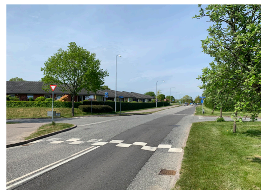
Etablering af ny enkeltrettet cykelsti på østsiden af Fårupvej.
