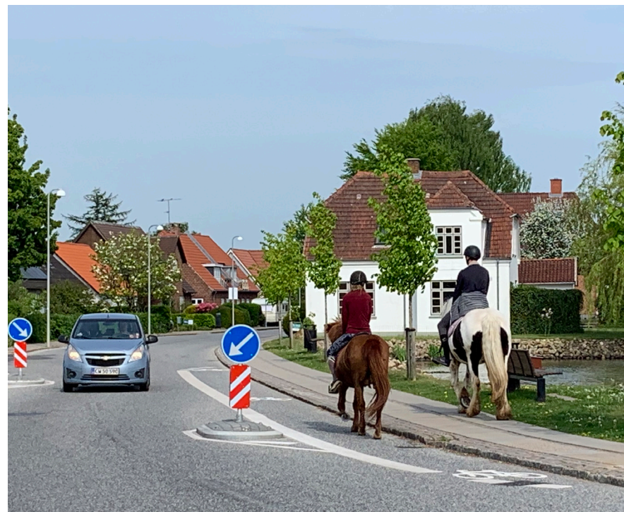
På Vejlevej er der opsat chikaner for at sænke farten.
