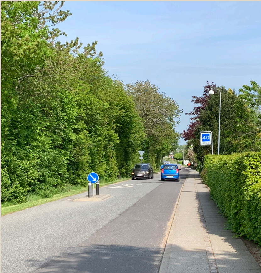
Amhøjvej ombygges til 2-1 vej, så der bliver bedre plads til cyklister. Der laves forbud mod gennemkørende tung trafik.
