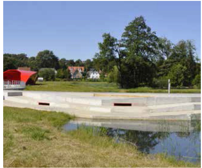
Vandtrappe som overløb
