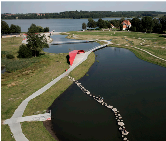
Trædesten som erosionsbarriere
