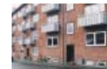
Mindegade nr. 16 og 18. Ønsket om lys og luft blev indfriet ved hjælp af altaner til gaden og til gården.
