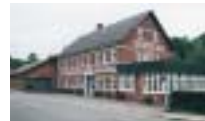
Grejsdalsvej 384, Grejsdalens Hotel. Kroen, køreladen og verandaen er bevaringsværdige elementer. Det tunge tag misklæder verandaen.
