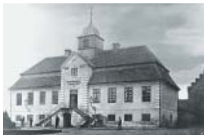
Vejles tredje rådhus, som blev opført i 1780. Det indeholdt både by- og herredstingstue, arrestlokaler, rådstuesalen og værelser til vægterne.
