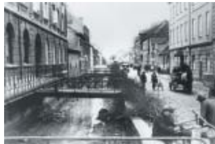
Klar til et af de største anlægsarbejder i Vejle i 1930'erne. Mølløden blev rørlagt (1932-1939), så Dæmningen kunne blive bredere. Til venstre ses Hotel Vejle, nu Teknisk Forvaltning.
