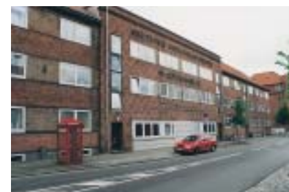
Vardevej nr. 11, opført 1932. Den meget smukke funktionsfacade fortjener vinduer, der passer til bygningen.
