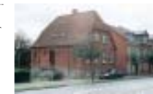
Horsensvej nr. 22, opført i 1920'erne. Bedre Byggeskik-stilens indflydelse ses tydeligt.
