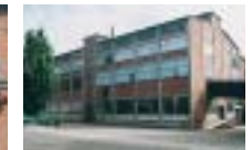
Denne bygning er opført i 1950'erne. Konstruktionen med udningering af tegl er typisk for perioden.
