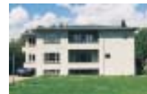
Runde vinduer og svævende altaner er elementer i arkitektur, der ønsker at udfordre tyngdekraften.
