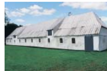
Slede, Bommerhavevej nr. 50. Et fint eksempel på, hvordan enkle materialer som pandeplader og facadens kalkning giver en smuk helhed.
