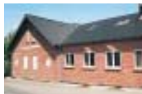
Horstedvej 5b, Højen Forsamlingshus opført i 1946.
