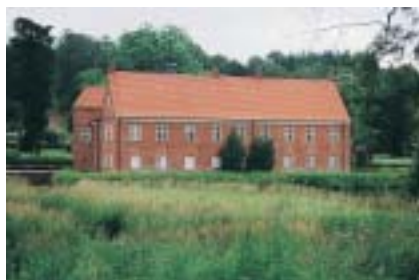
Tirsbæk er opført omkring 1540. Spiret bag vestfløjen er fra 1916, hvor der gennemførtes en større restaurering. Vestfløjen er opført i krydsforbandt. Vinduernes jævne fordeling giver facaden harmoni.
