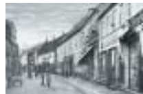
Torvegade i 1890'erne. Ejendommen med de to bygter efter hattemager Nielsens forretning med markise var endnu amtsgård for Vejle Amt. Den blev først afløst af en ny i 1900.
