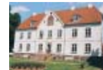
Den nyrestaurerede hovedbygning set fra haven.
