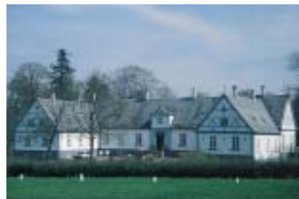
Lerbæks hovedbygning blev i 1890 gennemgribende ombygget til historicistisk stil med inspiration hentet fra renaissance arkitektur.
