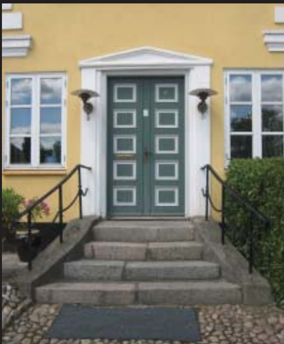
5 Vardevej 254 - ny dør, som er tilpasset de originale vinduer i form og farve
